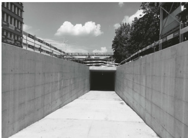
Noch im Rohbau: Zufahrtsrampe in der Kasernenstrasse. (Bild: TAZ)
