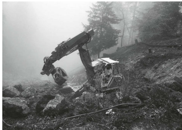
Arbeiten am Abhang: Schreitbagger am Döltschibach. (Bild: TAZ)
