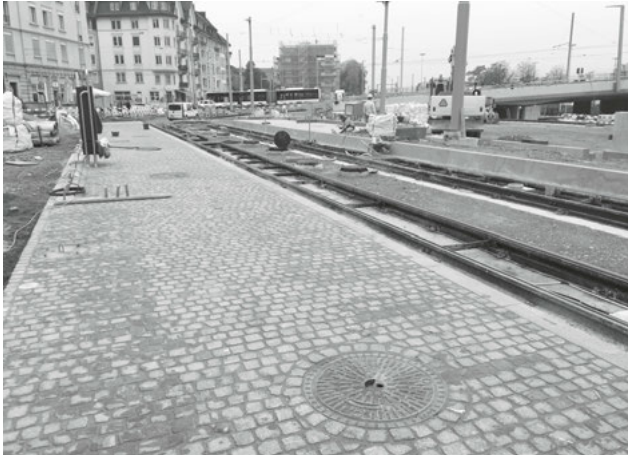
Neue Pflasterung in der Tramwendschleife am Hardplatz. (Bild: TAZ)
